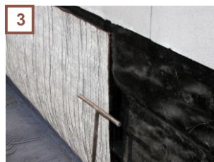
Устройство дренажа на битумную подложку
