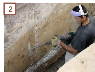
Подготовка основания перед креплением дренажного полотна
